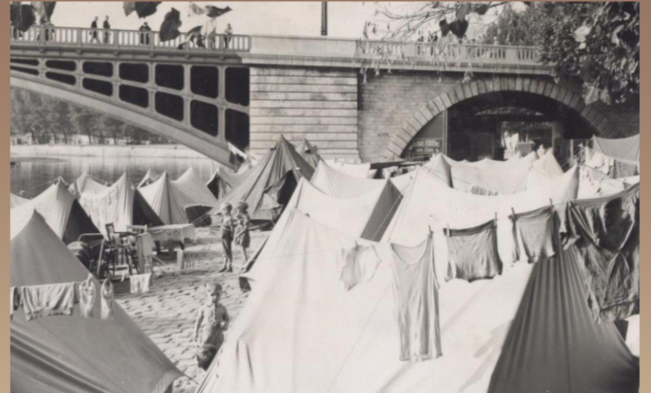
Les arches du Pont de Sully (Crédit photo : Emmaüs International)
